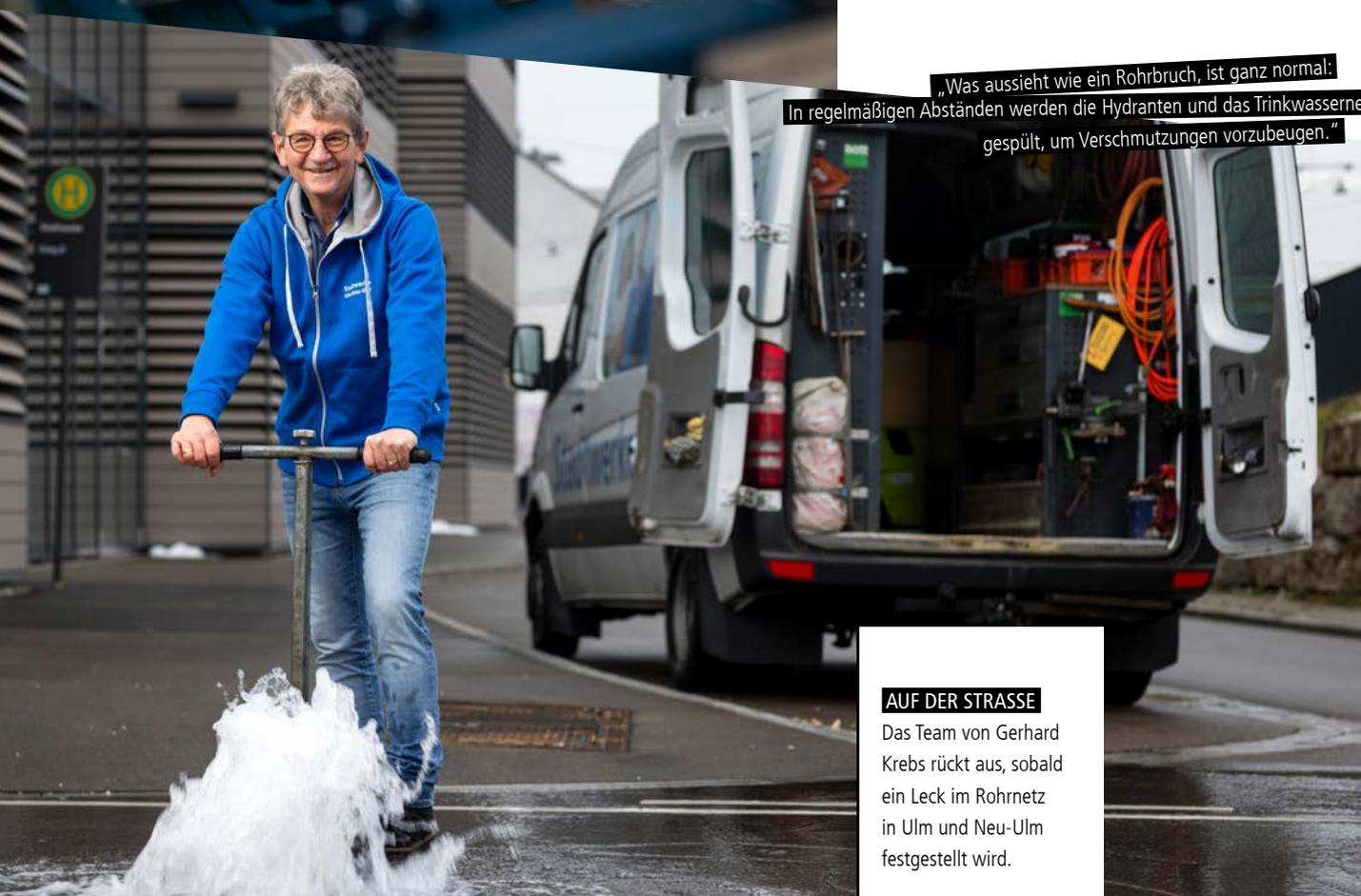
„Was aussieht wie ein Rohrbruch, ist ganz normal: In regelmäßigen Abständen werden die Hydranten und das Trinkwassernetz gespült, um Verschmutzungen vorzubeugen.“
